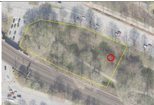
Abbildung 3: Notausgang (rot) zwischen Hauptbahnhof und Dammtor III mit BE-Fläche (gelb). 1
