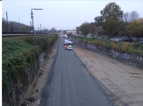
Abbildung 3: Blick auf den zugeschütteten Posttrog östlich der Bestandsgleise.
