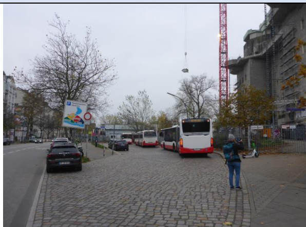
Abbildung 2: Blick von der U-Bahnstation Feldstraße auf den Flakturm Heiligengeistfeld.
