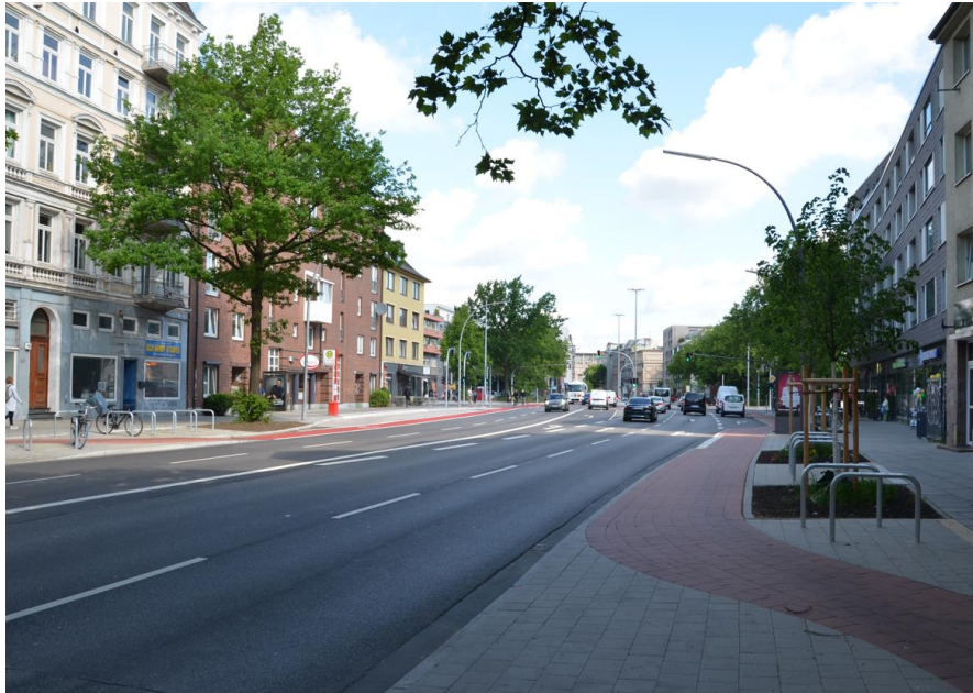
Abbildung 199: Holstenstraße – Blick Richtung Norden (Foto: SSF Ingenieure AG)
