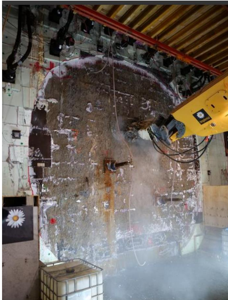
Abbildung 242 Anschlagwand des Tunnels, nachdem der Baugrund gefroren wurde. (Quelle: Amberg Engineering)
