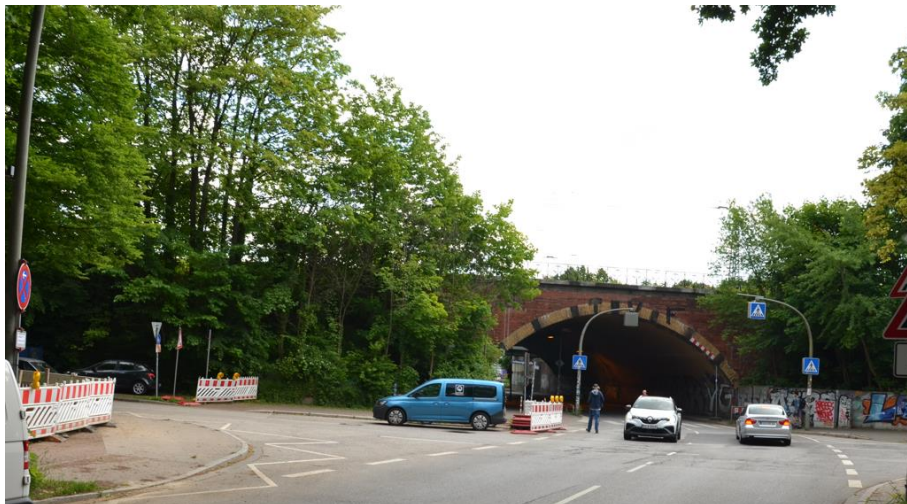
Abbildung 231: Plöner Unterführung – Blick Richtung Osten (Foto: SSF Ingenieure AG)
