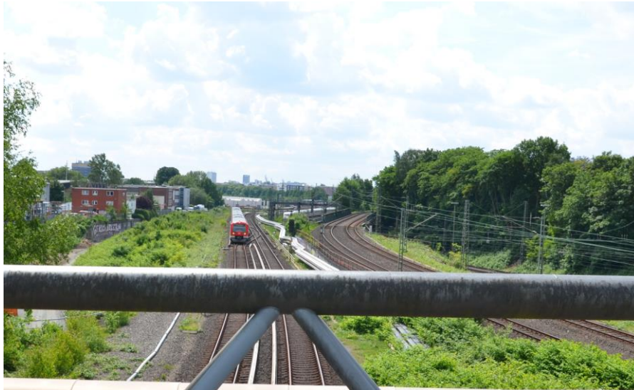
Abbildung 232: Bahndamm Diebsteich, Höhe Holstenkampbrücke – Blick Richtung Süden (Foto: SSF Ingenieure AG)
