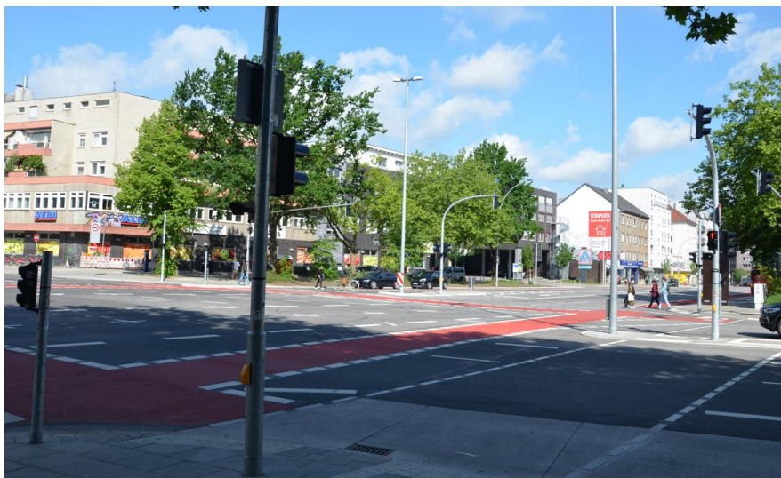
Abbildung 198: Kreuzung Max-Brauer-Allee/ Holstenstraße – Blick Richtung Nordwest (Foto: SSF Ingenieure AG)
