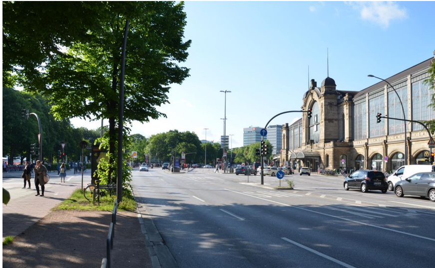
Abbildung 166: Edmund-Siemers-Allee am Dammtor – Blick nach Osten (Foto: SSF Ingenieure AG)
