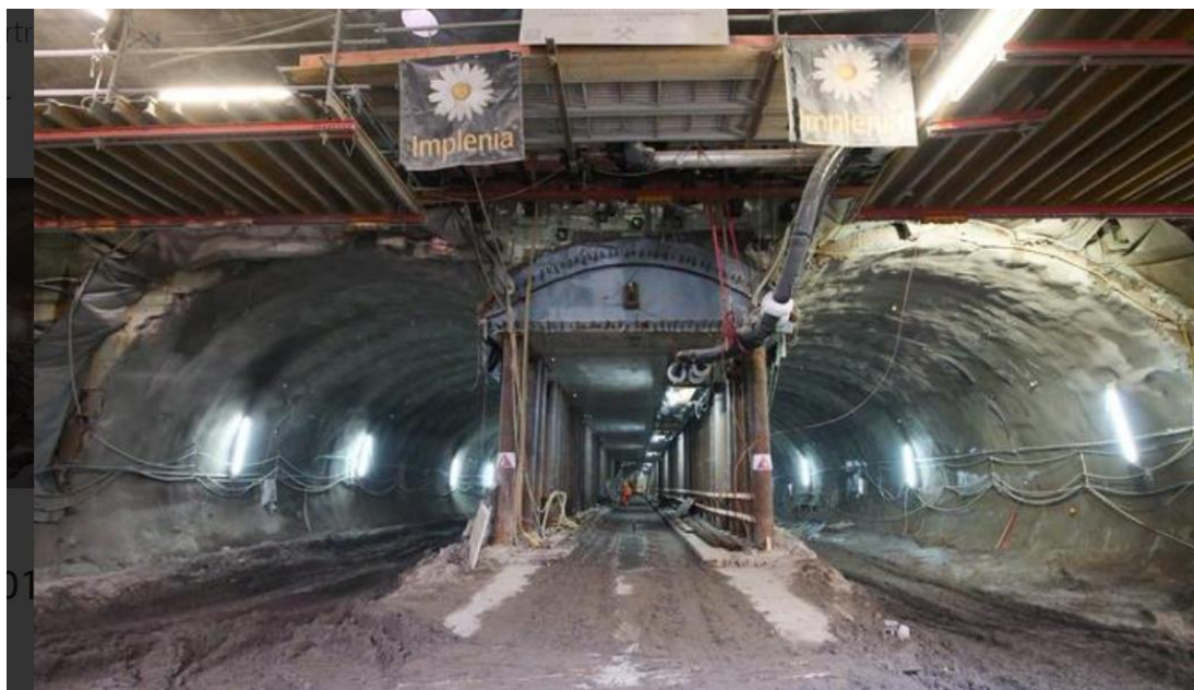
Abbildung 243 Fertiger Ausbruch der Aufweitung aus den zwei TBM-Tunnelröhren. (Quelle: Amberg Engineering)
