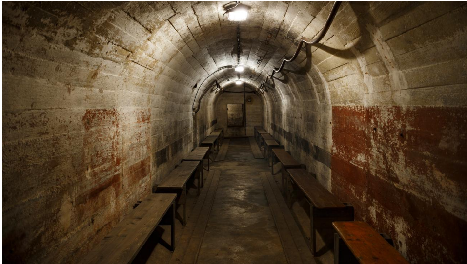
Abbildung 72: Beispiel eines Röhrenbunkers in Hamburg [U33]
